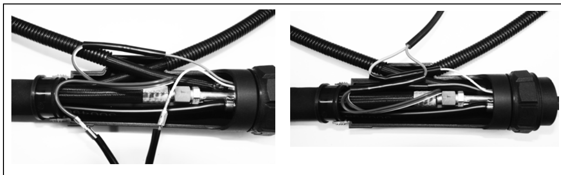
Fig. 17 Connecter le câble de bouton avec le câble du contrôleur de débit Monter la gaine thermorétractable d'isolation
