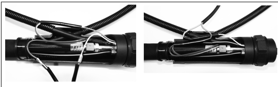
Afb. 17 Stuurleiding verbinden met kabel doorstroomzekering Krimpkous aanbrengen voor isolatie
