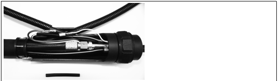
Abb. 16 Eine Tasterleitung demontieren
